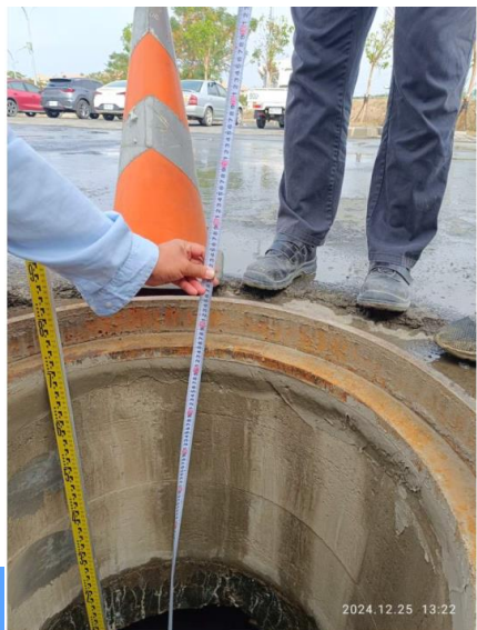
箱涵人孔深度量測符合原核定計畫。
