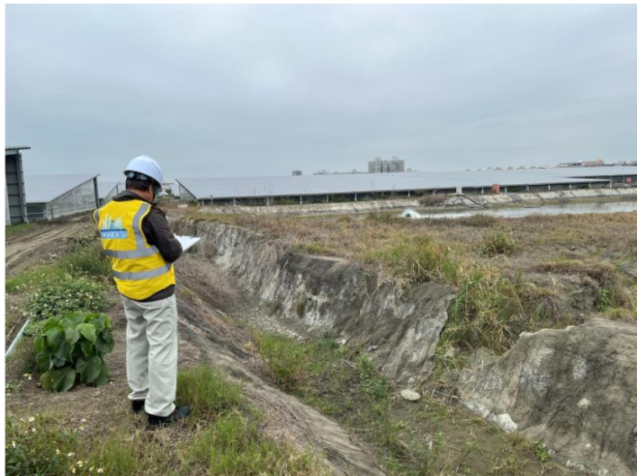
臨時排水溝(以既有土溝替代)未淤積
