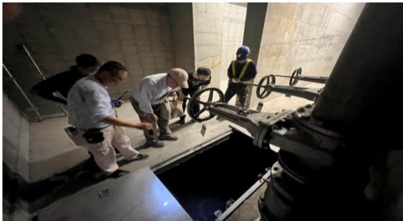
抽水機機組設備交替運轉測試
